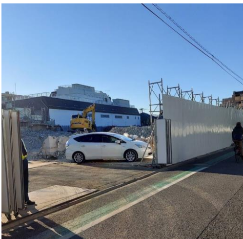
1月20日現在の保育園解体現場
